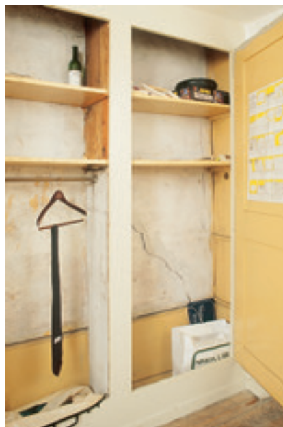
Exposition Aménagement , 1990-1991 Installation de Simon Lamunière © Archives M/2. Photo: Georg Rehsteiner
